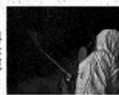
アスベスト処理
