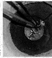
煙突アスベスト除去工法
