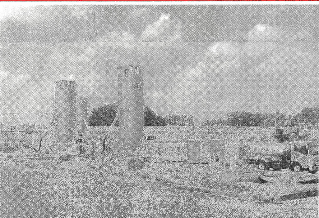
フジコーポレーションが自社処分場内で実施してきた工法が、放射性物質を含む焼却灰の溶出抑制に有効なことが分かった
